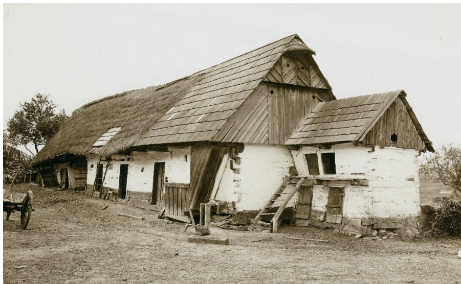
Obr. 79 Hospodářské stavení z Přeloučka
