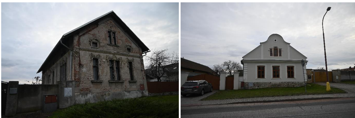
Obr. 18 a 19 Památkově chráněný venkovský secesní dům č. p. 5 a venkovské stavení na návsi v Dolanech
